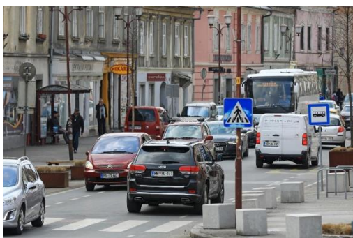
Slika 1: Koroška cesta pred obnovo (vir: Večer, 2019)
